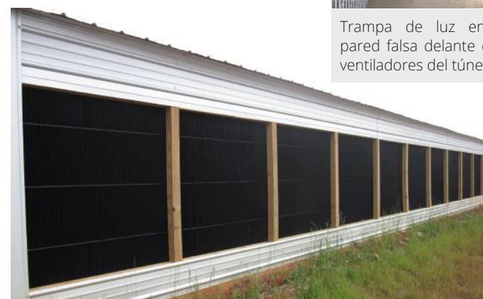
Trampa de luz de la cortina o puerta de túnel de túnel.
