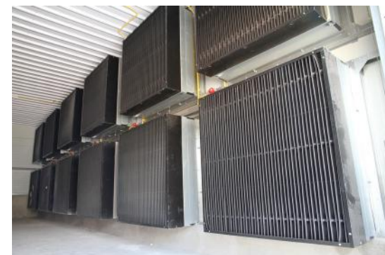
Las trampas de luz montadas sobre ventiladores pueden reducir el funcionamiento de los ventiladores y no son la mejor opción en las casetas de túnel de alta velocidad.
