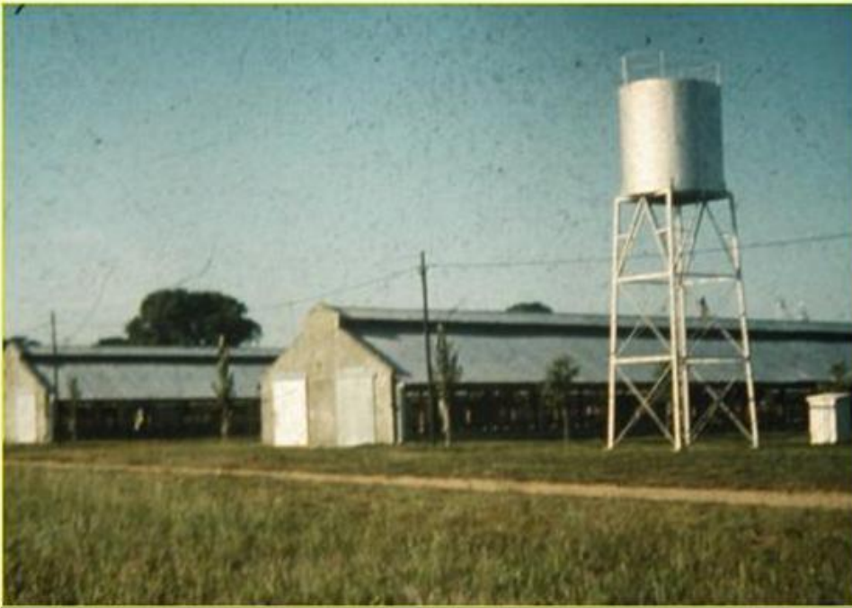
Deposito de agua y equipo de bombeo
